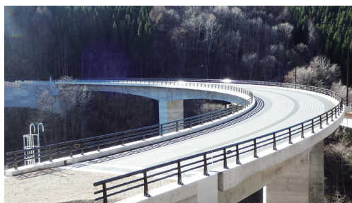
PC連続ラーメン橋
