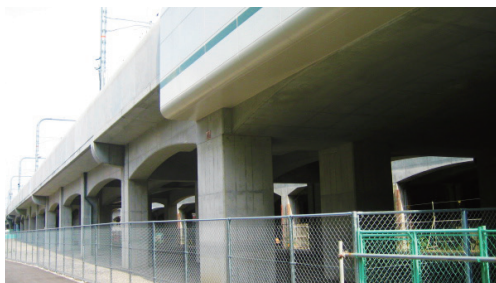
RCラーメン高架橋
