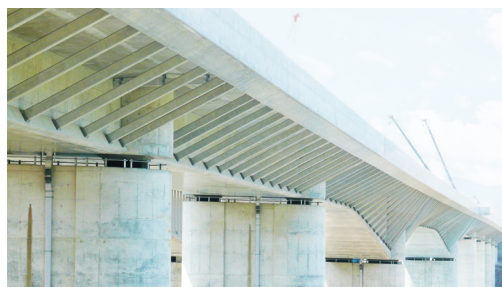
PC連続箱桁橋
