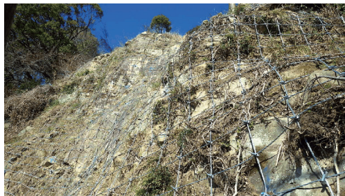
ロープ伏せ工
