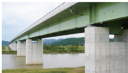
鋼連続2主桁橋
