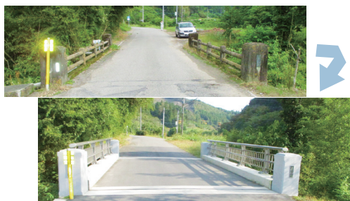
橋梁補修設計(補修前・補修後)
