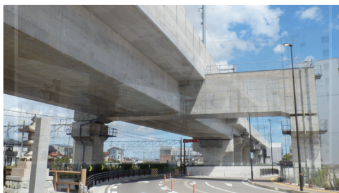
道路交差部の特殊橋梁
