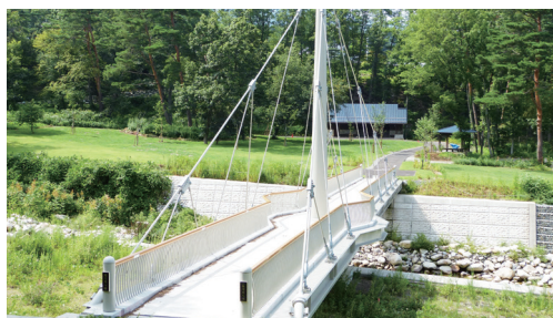
自定式吊り橋
