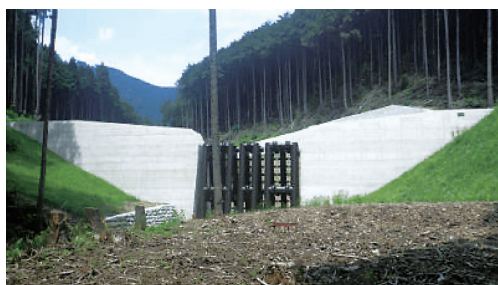
透過型砂防えん堤
