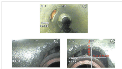
管渠内カメラ調査
