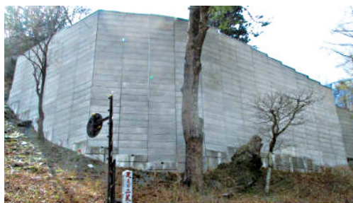
急傾斜軽量盛土工(EPS工法)の整備
