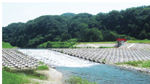
緩傾斜型床止め
