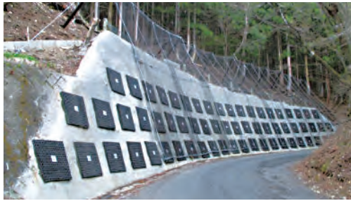
既設擁壁補強と落石対策計画
