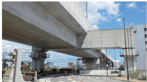
道路交差部の特殊橋梁
