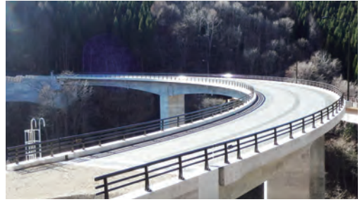
PC連続ラーメン橋
