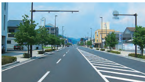
道路及び交差点整備
