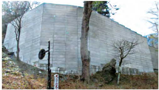
急傾斜軽量盛土工(EPS工法)の整備
