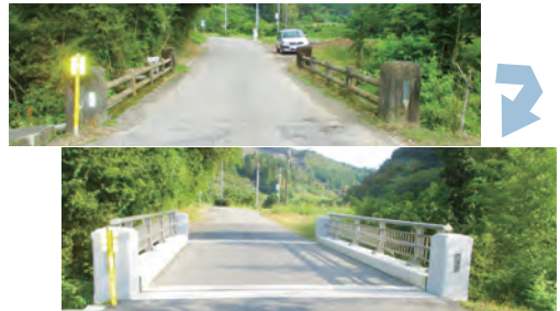
橋梁補修設計 (補修前・補修後)
