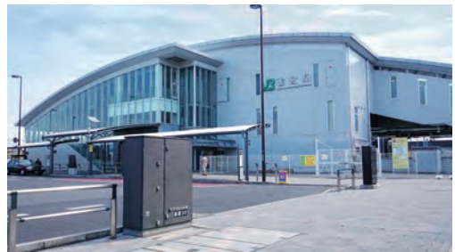
駅前広場整備及び電線共同溝
