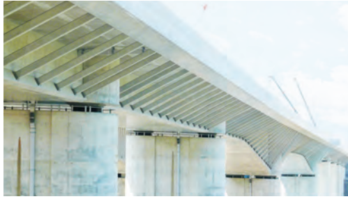
PC連続箱桁橋
