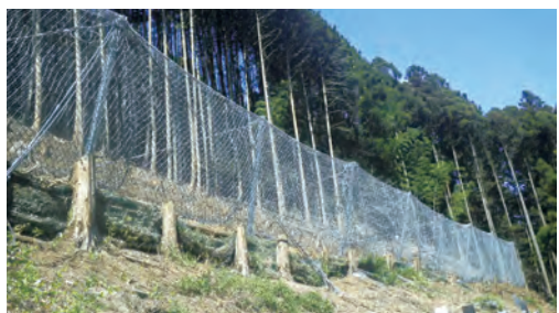
高エネルギー吸収型落石防護柵
