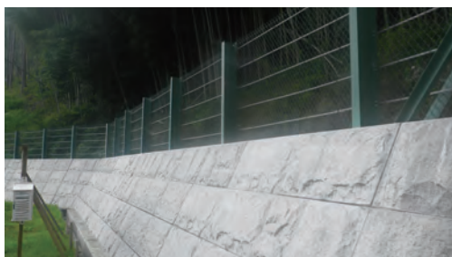
急傾斜地崩壊対策施設
