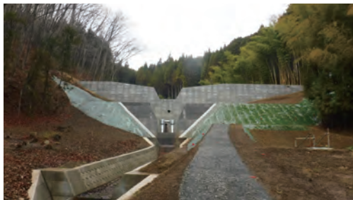
不透過型砂防えん堤
