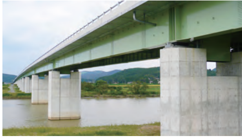
鋼連続2主桁橋
