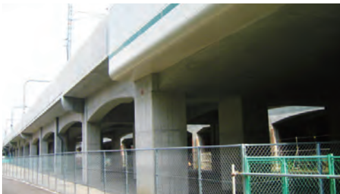
RCラーメン高架橋
