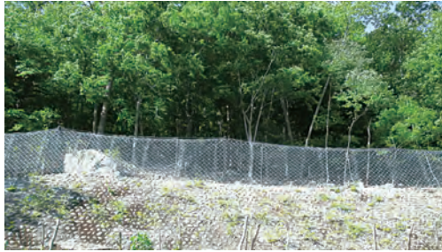
高エネルギー吸収型落石防護柵
