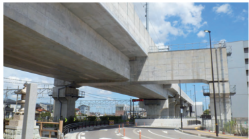
道路交差部の特殊橋梁
