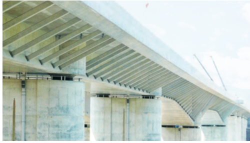
PC連続箱桁橋
