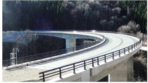
PC連続ラーメン橋
