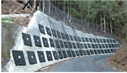
既設擁壁補強と落石対策計画
