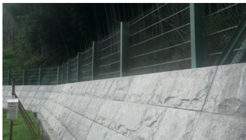
急傾斜地崩壊対策施設
