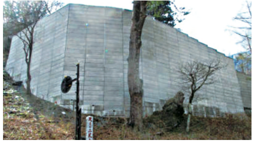
急傾斜軽量盛土工(EPS工法)の整備
