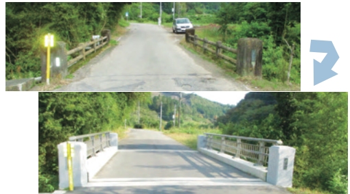
橋梁補修設計 (補修前・補修後)
