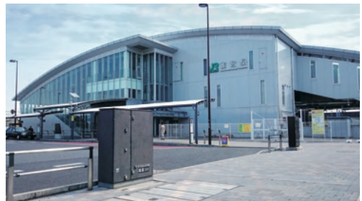
駅前広場整備及び電線共同溝
