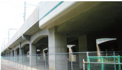
RCラーメン高架橋
