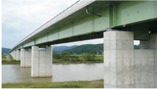
鋼連続2主桁橋
