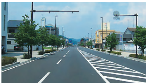
道路及び交差点整備
