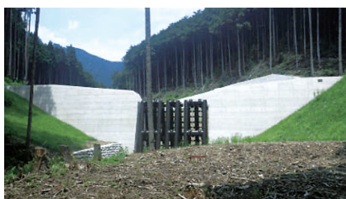
透過型砂防えん堤
