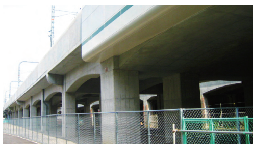
RCラーメン高架橋
