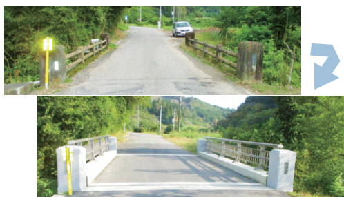
橋梁補修設計(補修前・補修後)
