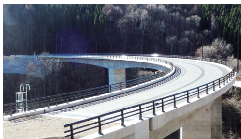
PC連続ラーメン橋
