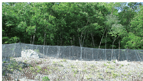
高エネルギー吸収型落石防護柵
