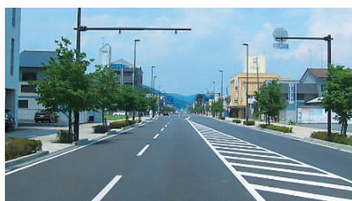
道路及び交差点整備
