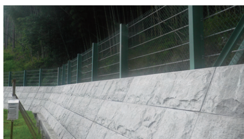
急傾斜地崩壊対策施設
