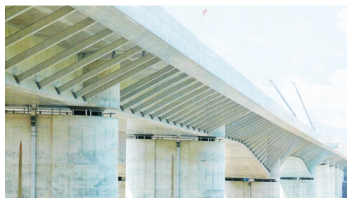
PC連続箱桁橋
