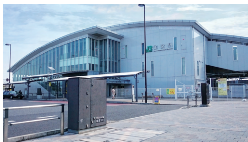
駅前広場整備及び電線共同溝
