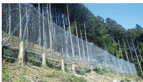
高エネルギー吸収型落石防護柵
