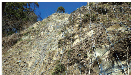
ロープ伏せ工
