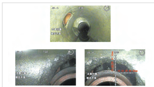
管渠内カメラ調査
