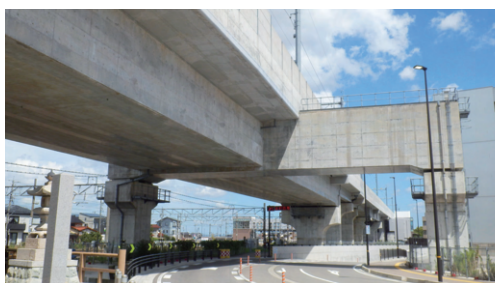
道路交差部の特殊橋梁
