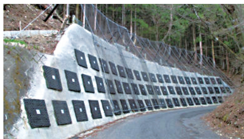
既設擁壁補強と落石対策計画
