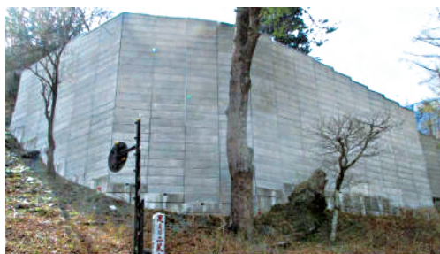
急傾斜軽量盛土工(EPS工法)の整備
