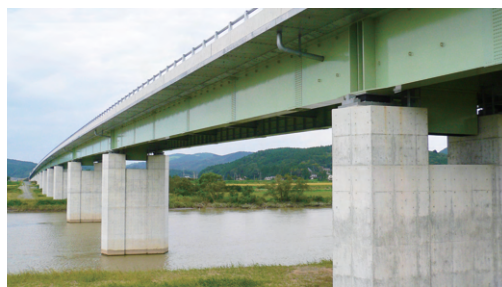
鋼連続2主桁橋
