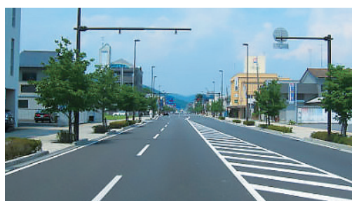
道路及び交差点整備
