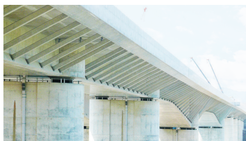
PC連続箱桁橋
