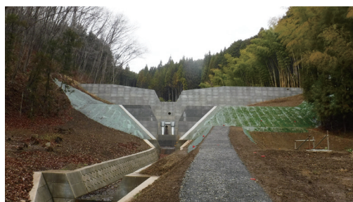
不透過型砂防えん堤
