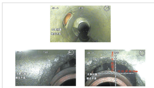
管渠内カメラ調査
