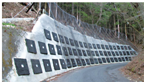
既設擁壁補強と落石対策計画
