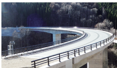
PC連続ラーメン橋
