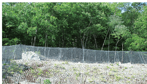
高エネルギー吸収型落石防護柵
