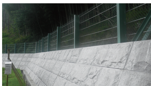
急傾斜地崩壊対策施設
