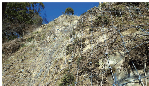
ロープ伏せ工
