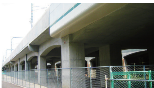
RCラーメン高架橋
