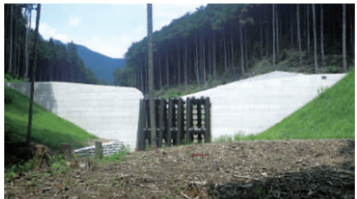
透過型砂防えん堤
