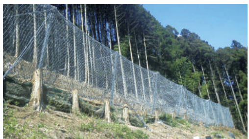
高エネルギー吸収型落石防護柵
