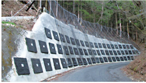
既設擁壁補強と落石対策計画
