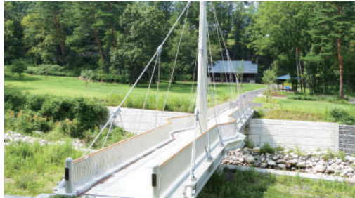
自定式吊り橋
