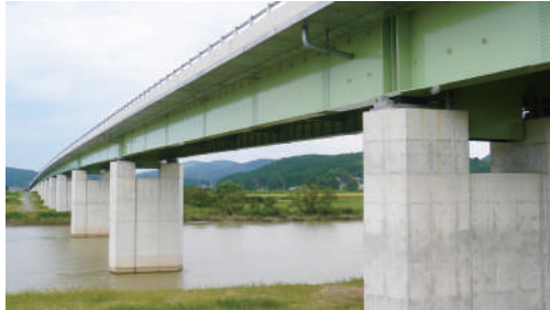
鋼連続2主桁橋
