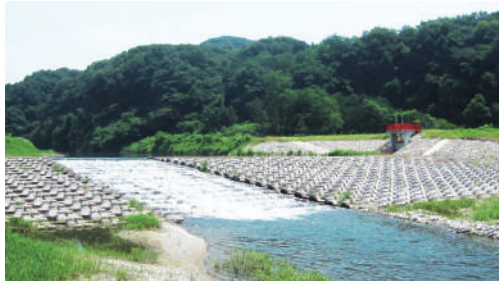
緩傾斜型床止め
