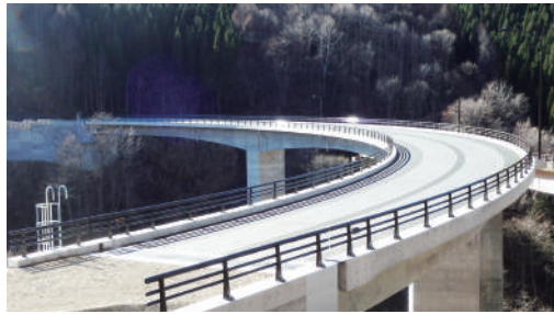
PC連続ラーメン橋
