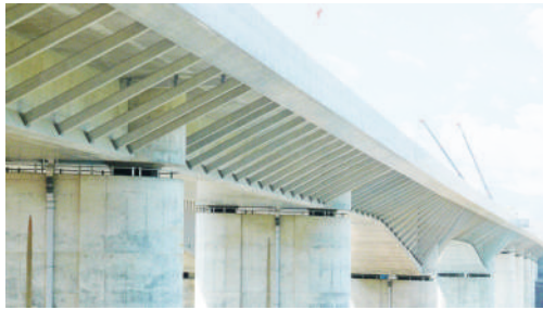
PC連続箱桁橋
