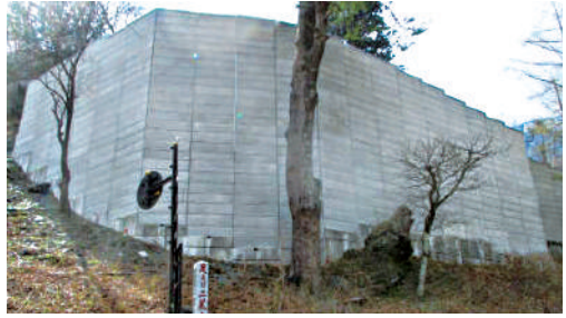
急傾斜軽量盛土工(EPS工法)の整備
