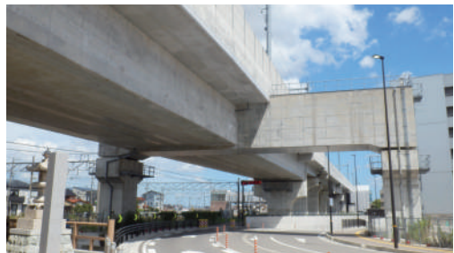
道路交差部の特殊橋梁
