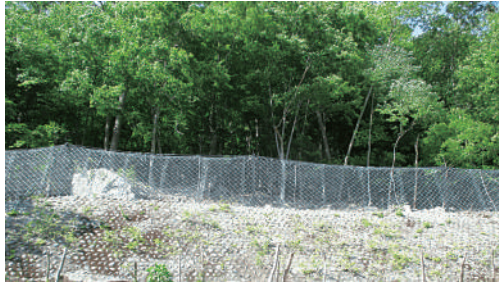
高エネルギー吸収型落石防護柵
