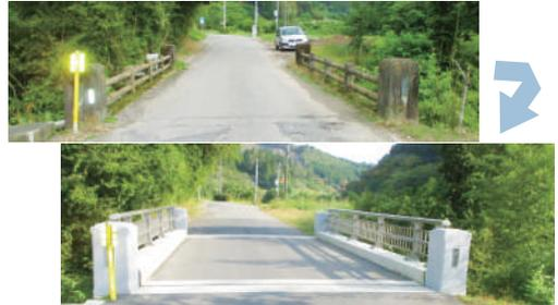
橋梁補修設計(補修前・補修後)
