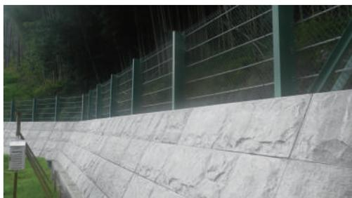
急傾斜地崩壊対策施設
