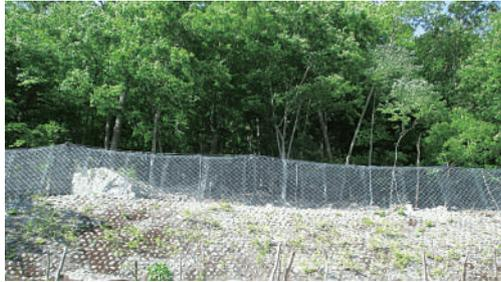
高エネルギー吸収型落石防護柵
