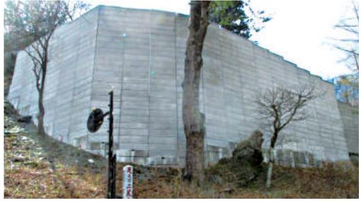
急傾斜軽量盛土工(EPS工法)の整備
