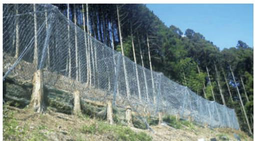
高エネルギー吸収型落石防護柵
