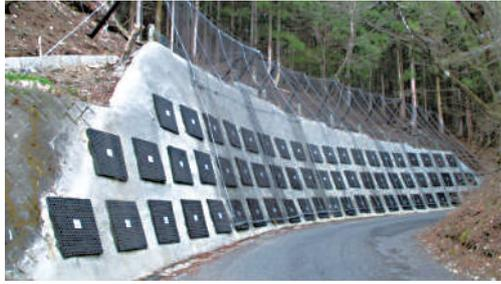
既設擁壁補強と落石対策計画
