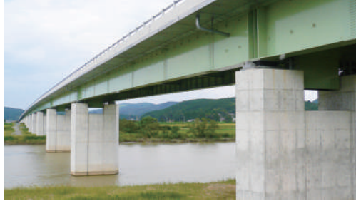
鋼連続2主桁橋
