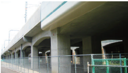
RCラーメン高架橋
