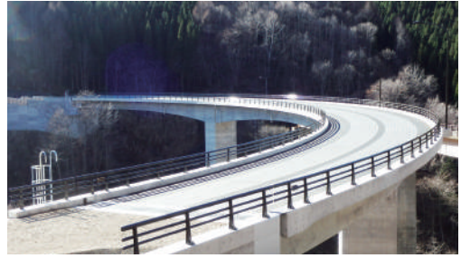
PC連続ラーメン橋
