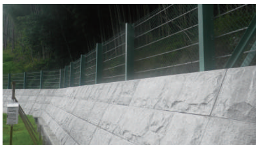
急傾斜地崩壊対策施設
