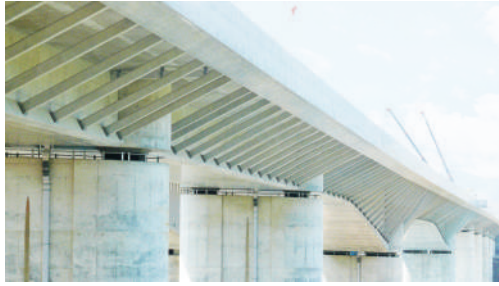
PC連続箱桁橋
