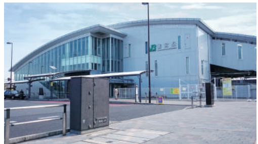
駅前広場整備及び電線共同溝
