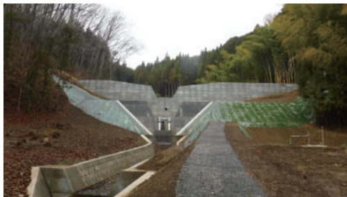
不透過型砂防えん堤
