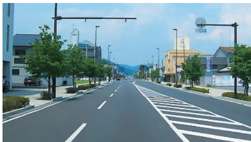
道路及び交差点整備
