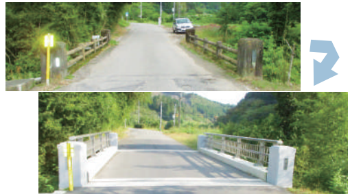
橋梁補修設計(補修前・補修後)
