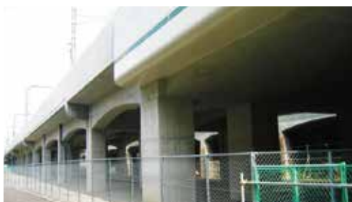
RCラーメン高架橋
