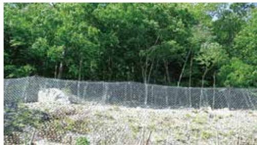
高エネルギー吸収型落石防護柵
