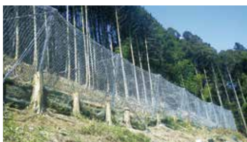
高エネルギー吸収型落石防護柵
