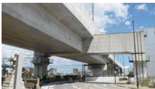
道路交差部の特殊橋梁
