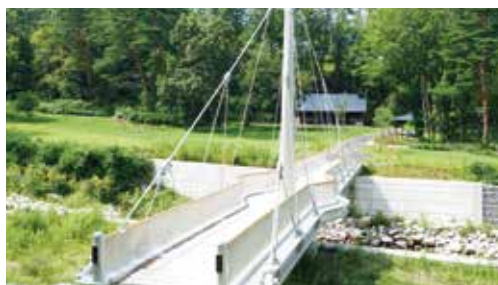
自定式吊り橋
