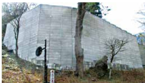
急傾斜軽量盛土工(EPS工法)の整備
