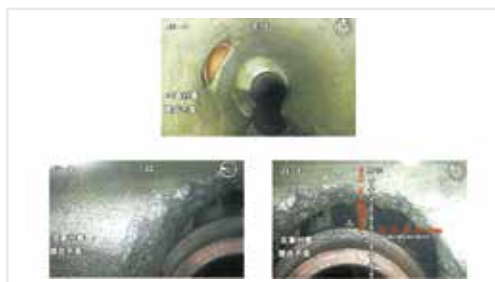
管渠内カメラ調査
