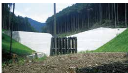
透過型砂防えん堤
