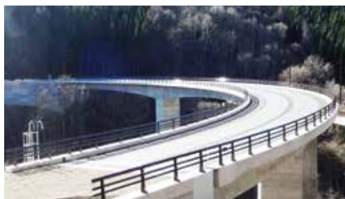
PC連続ラーメン橋
