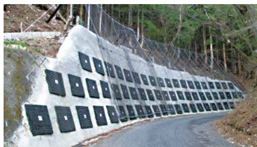
既設擁壁補強と落石対策計画
