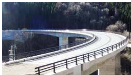
PC連続ラーメン橋
