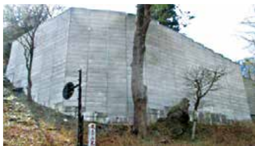
急傾斜軽量盛土工(EPS工法)の整備
