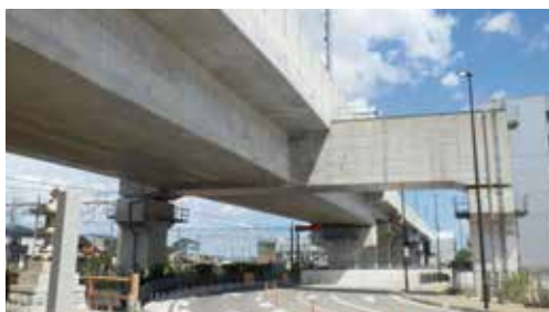
道路交差部の特殊橋梁
