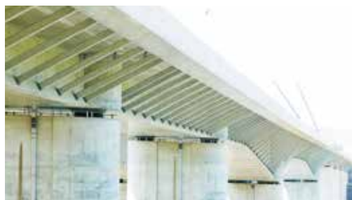
PC連続箱桁橋
