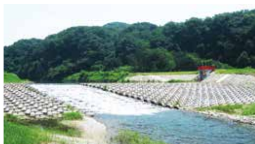
緩傾斜型床止め
