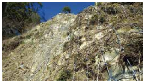
ロープ伏せ工
