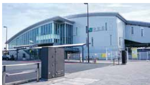
駅前広場整備及び電線共同溝
