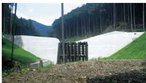
透過型砂防えん堤
