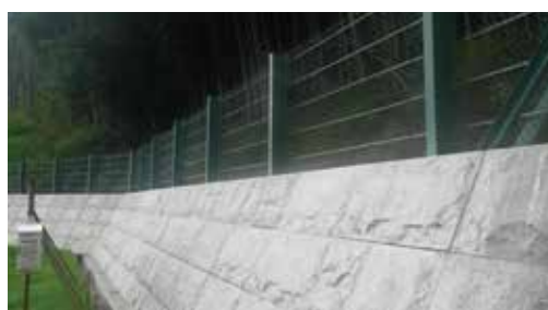
急傾斜地崩壊対策施設
