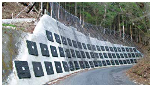
既設擁壁補強と落石対策計画
