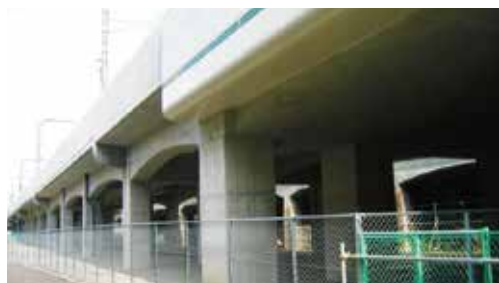
RCラーメン高架橋
