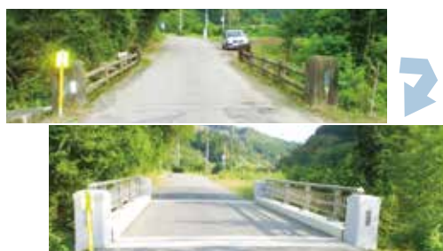
橋梁補修設計(補修前・補修後)
