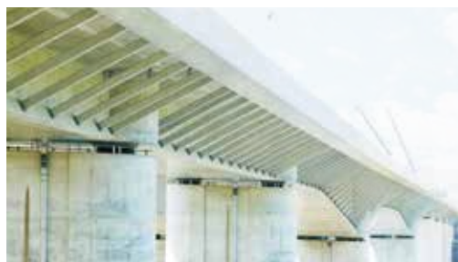
PC連続箱桁橋
