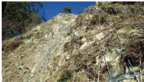
ロープ伏せ工
