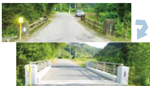
橋梁補修設計(補修前・補修後)
