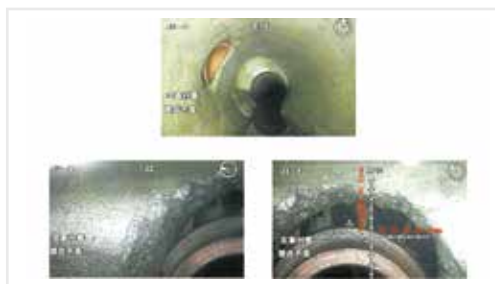
管渠内カメラ調査
