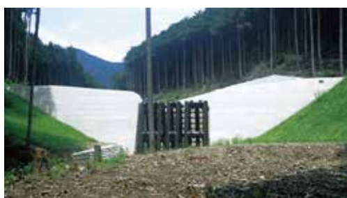
透過型砂防えん堤
