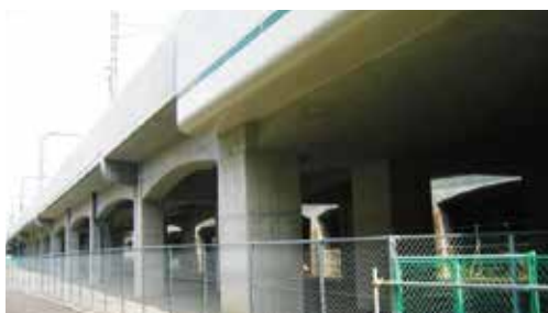
RCラーメン高架橋
