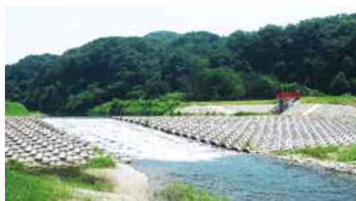
緩傾斜型床止め
