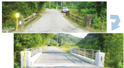
橋梁補修設計 (補修前・補修後)
