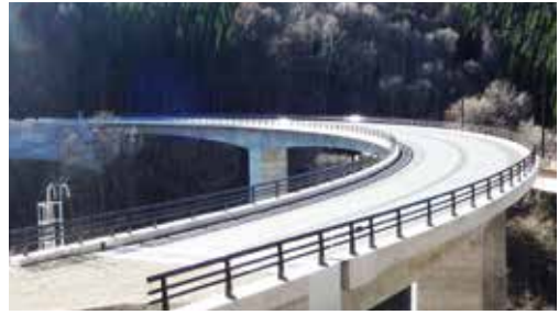
PC連続ラーメン橋
