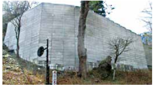
急傾斜軽量盛土工(EPS工法)の整備
