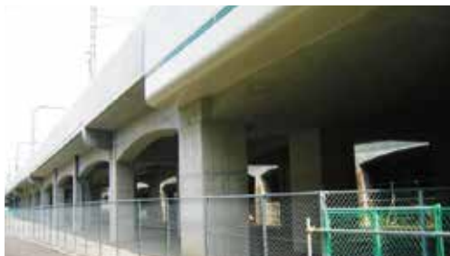
RCラーメン高架橋
