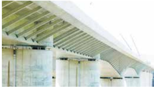
PC連続箱桁橋
