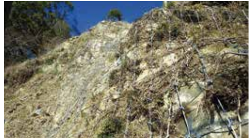
ロープ伏せ工
