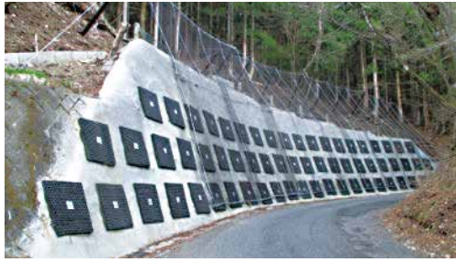
既設擁壁補強と落石対策計画
