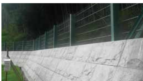
急傾斜地崩壊対策施設
