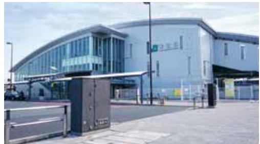
駅前広場整備及び電線共同溝
