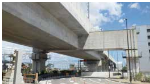
道路交差部の特殊橋梁
